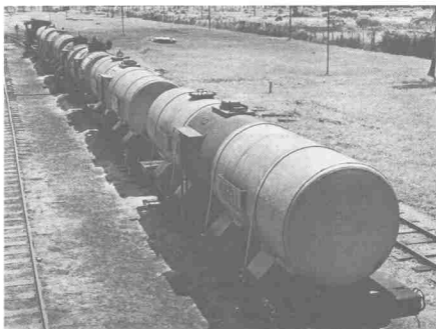
Keretapi membawa minyak ke Depoh Shell (Dekat Pelabuhan).
