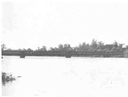
Jambatan Keretapi Sungai Bidor.
